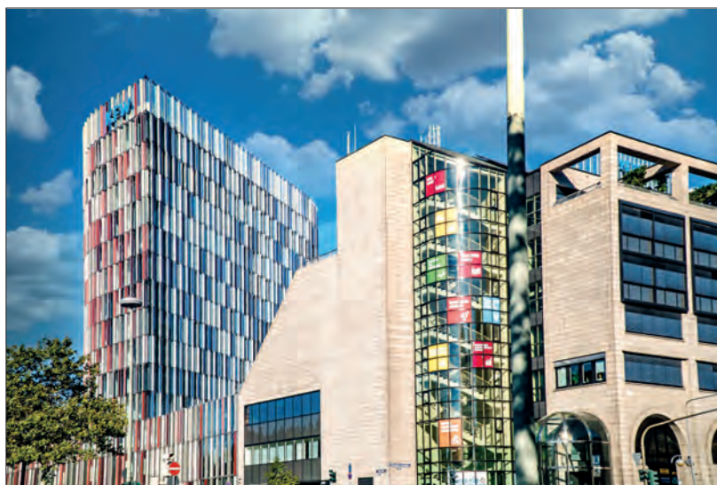
Markant: Die KfW-Zentrale an der Bockenheimer Warte in Frankfurt.
